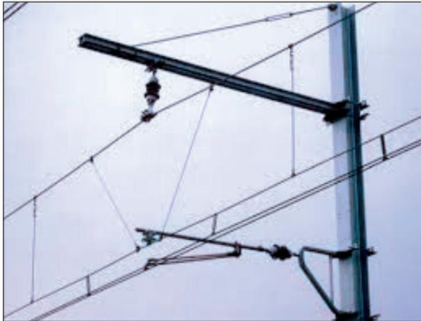
SNCF : console pour une seule voie en caténaire compound 1500 V. Les deux fils de contact sont ici bien visibles, de même que l'antibalançant (maintenant latéralement le câble porteur auxiliaire) et les deux biellettes, chacune pour un des deux fils de contact.
