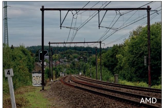
Portique « standard » constitué( d'une traverse fixée à deux poteaux – les trois sont des poutrelles en H. Les poinçons sont ici d'un modèle plus ancien, datant sans doute de l'électrification de la ligne (1956). Un câble « feeder » est suspendu à côté du porteur principal pour augmenter la section totale, chose souvent nécessaire en 3 kV.
