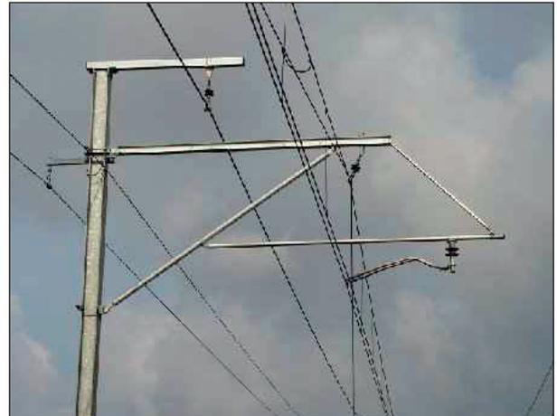
SNCB (Pardon, Infrabel!) : console pour une seule voie en caténaire récente 3 000 V. Ici aussi deux fils de contact bien visibles, de même que l'antibalançant maintenant les deux biellettes, chacune pour un des deux fils de contact. Ce dispositif remplace peu à peu le montage des premières électrifications.
